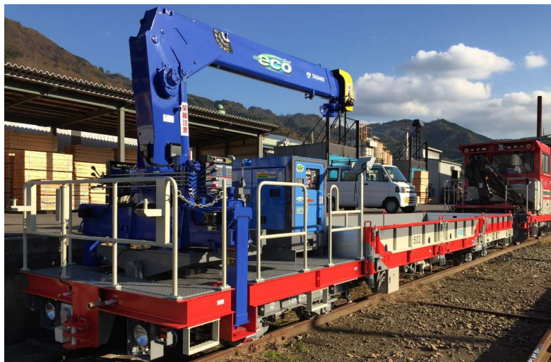
防災工事に伴う材料運搬
