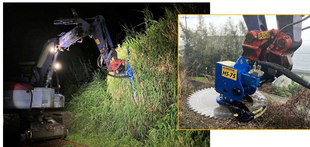
大型機械による沿線樹木の伐採
