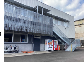
新築した統合事務所 （多度津工場）
